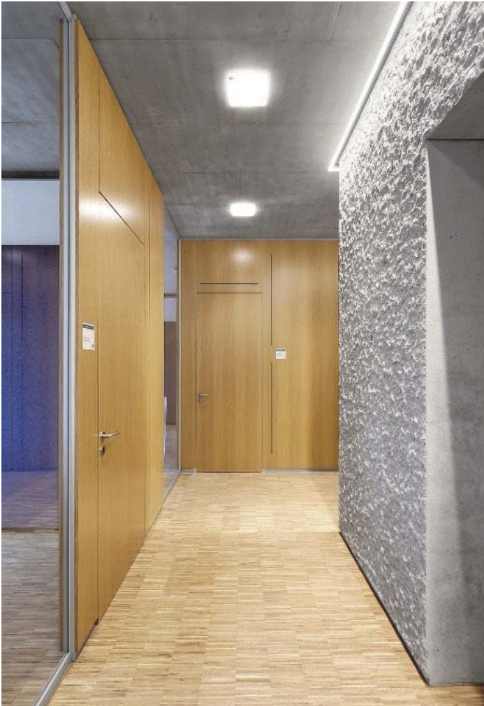
Die in Eiche furnierten, in die Ganzglaswände eingebundenen Türelemente sind als flächenbündige Portale zu den Büro- und Besprechungsräumen ausgebildet.
