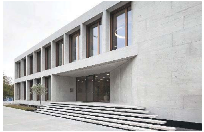
Es kommt darauf an, was man daraus macht: Der neue, zweigeschossige Pavillion in Sichtbeton ist die Visitenkarte des Besigheimer Bauunternehmens Karl Köhler.
