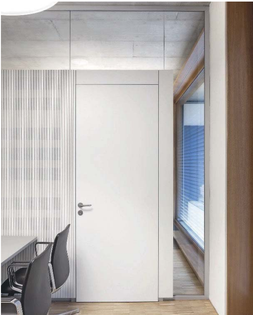
/ Akustisch wirksame Bürozwischenwände sorgen für eine gute Sprachverständlichkeit – verglaste Oberlichter und Anschlusschwerter schaffen Transparenz und Leichtigkeit.
