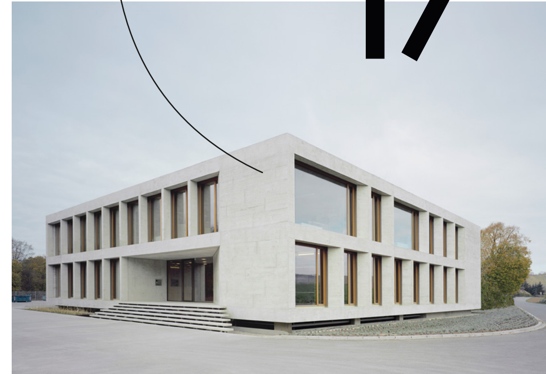
Durch den Einsatz von Ortbeton erhielt die Gebäudehülle ihren monolithischen Körper.
